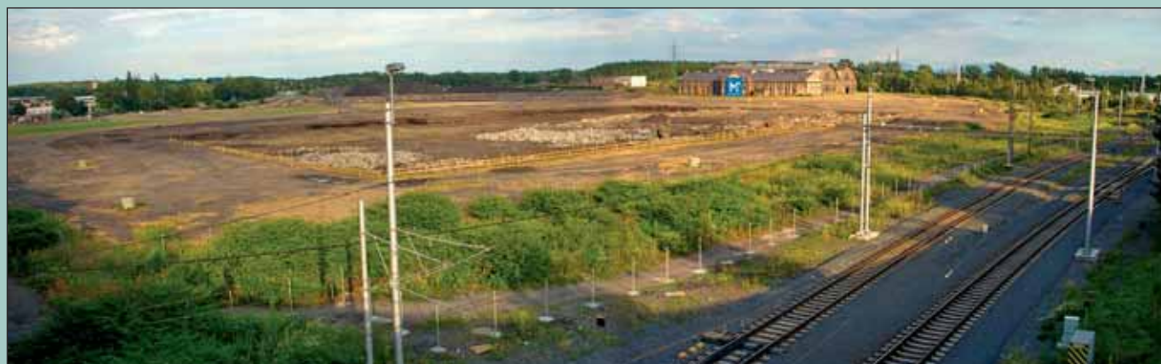
◀ Zahájení prací na výstavbě nového centra města Ostravy předcházela likvidace staré ekologické zátěže bývalé koksovny Karolína
