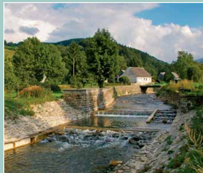
Povodně z konce 20. stol. si vyžádaly v intravilánech měst a obcí řadu následných morfologických zásahů do koryta řeky Bělé
