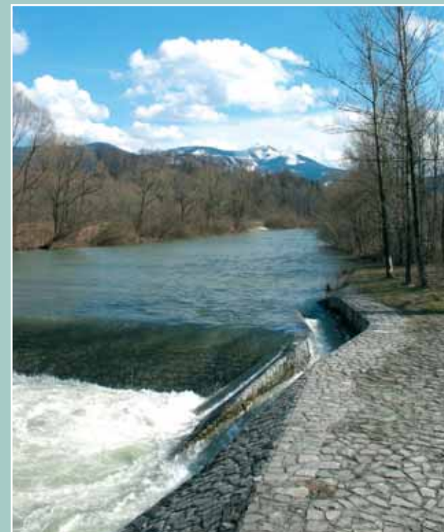
Zřízení přírodního spádového stupně (na Morávce) a rybích přechodů na nových nebo rekonstruovaných říčních objektech (na Ostravici) rovněž spadá do revitalizace říčních systémů
