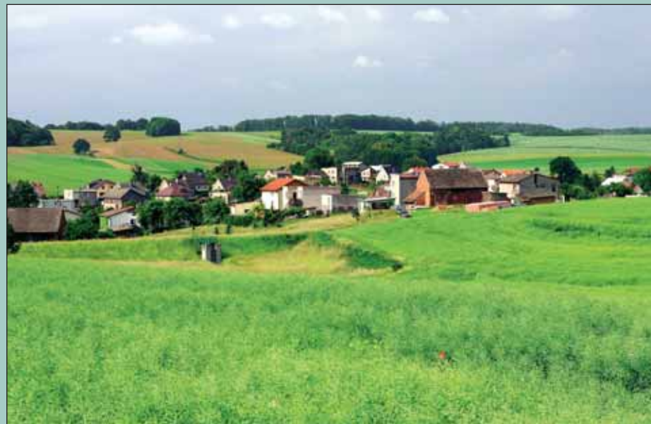
Suchá nádrž na bezejmenném přítoku potoka Bečvy nad obcí Hať ►
