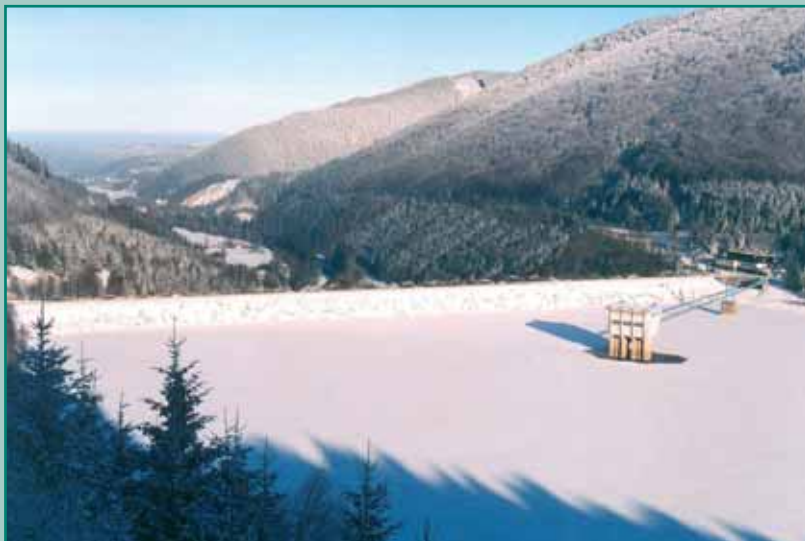
Vodárenská údolní nádrž Šance na Ostravici
