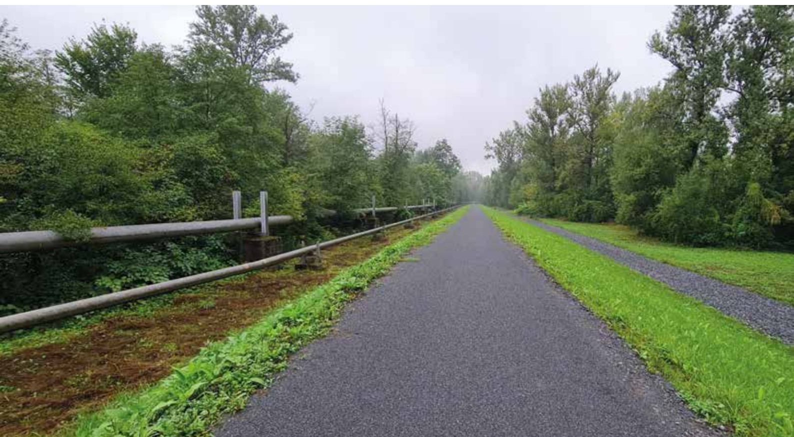
LB hráze podél toku Ostravice v Paskově po výstavbě
