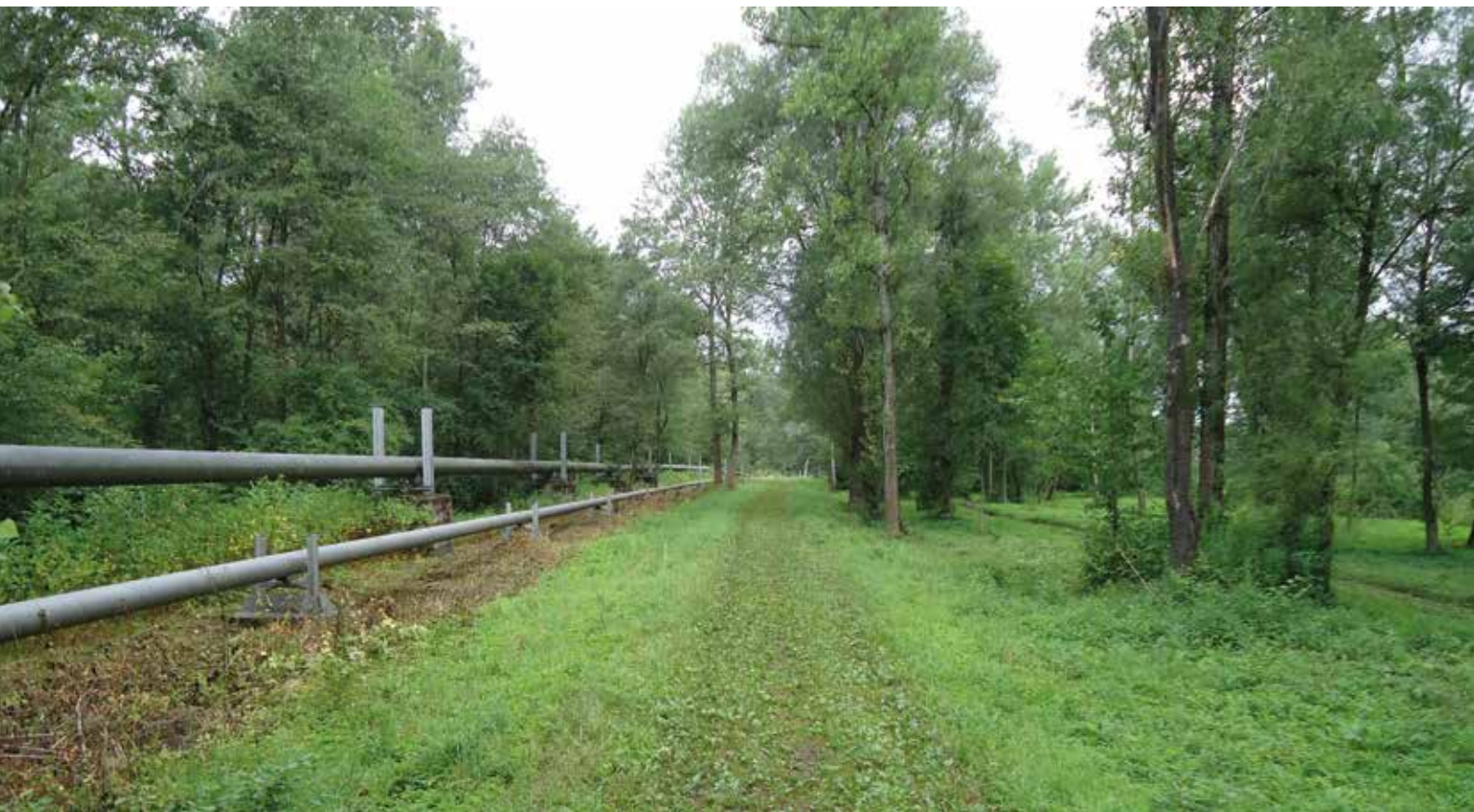
LB hráze podél toku Ostravice v Paskově před výstavbou
