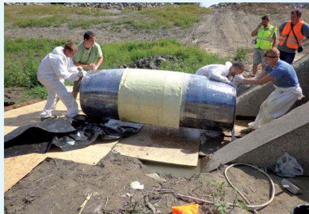
Provádění krátkých vložek
