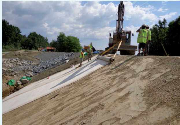
Pokládka bentonitové rohože
