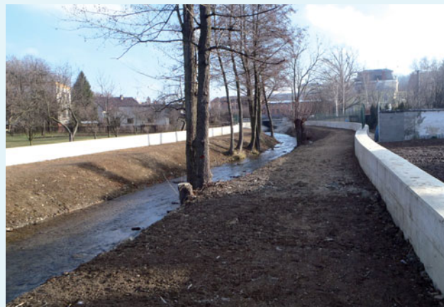
Protipovodňové nábrežní zídky
