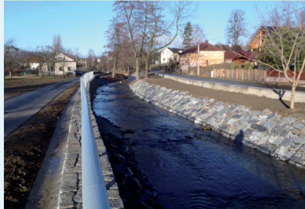
Betonová opěrná zeď s kamenným obkladem v souběhu s komunikací
