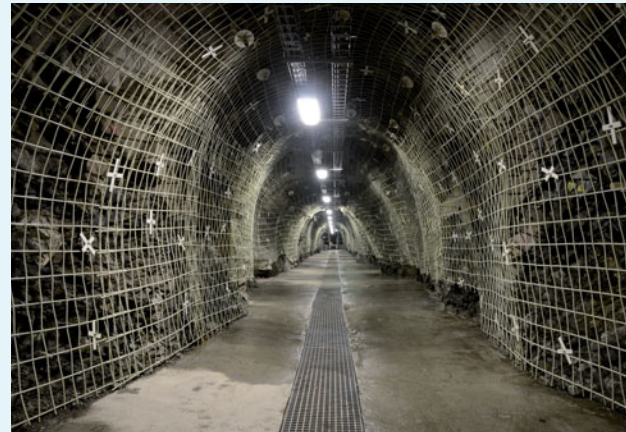
Drenážní štola po dokončení
