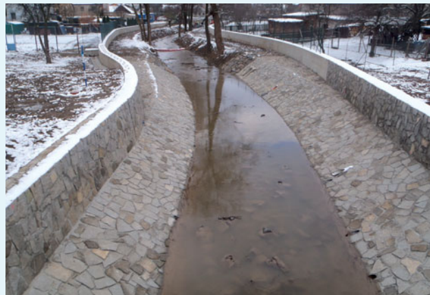
Upravený nátok pod silniční most
