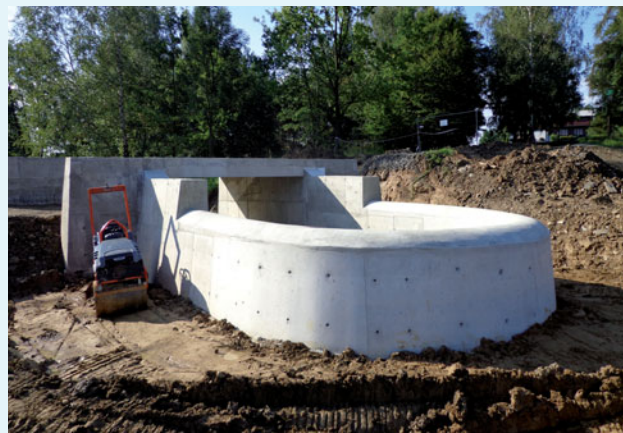
Přelivná hrana bezpečnostního přelivu
