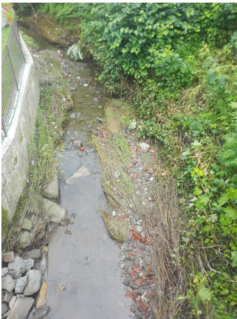
Stavební suť do vodního toku nepatří
