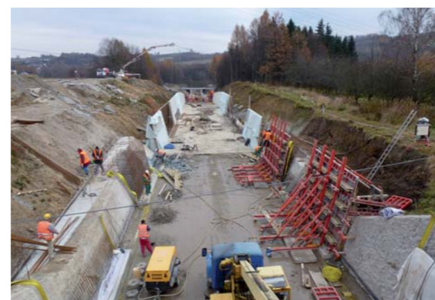
Těřlicko – výstavba nového skluzu
