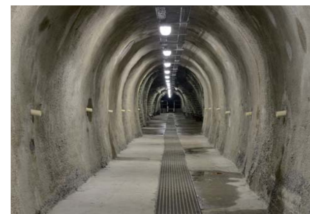
Šance – drenážní štola
