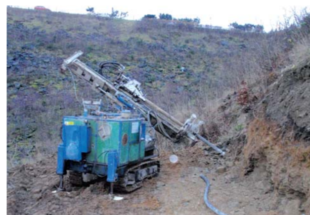
Šance – hřebíkování svahu nad stavební jámou
