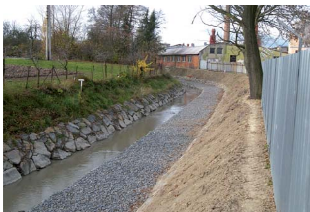
Porubka – hotový úsek zpěvněné bermy
