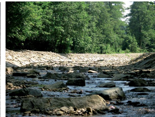
Výstavba účinné drsnosti na bystřině Týra
