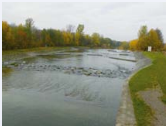
Drátokamenné výhony na řece Morávce.
