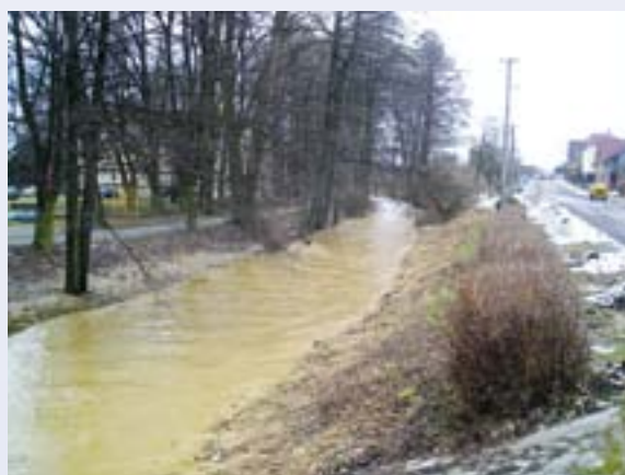
Povodně na Porubce v Ostravě-Svinově ohrožují nemovitosti i technickou infrastrukturu. Akce „Úprava Porubky, Ostrava-Svinov“ zajistí ochranu před povodněmi do výše průtoku Q_{20} .
