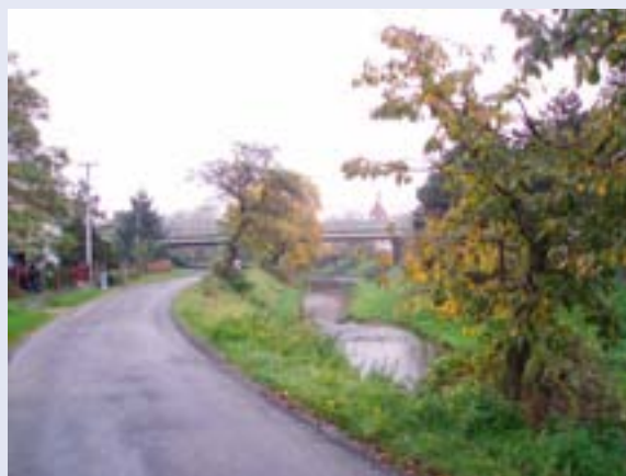
Současný stav vodního toku Ondřejnice. Akce „Úprava Ondřejnice, Stará Ves nad Ondřejnicí“ zajistí ochranu obce proti dvacetileté vodě.
