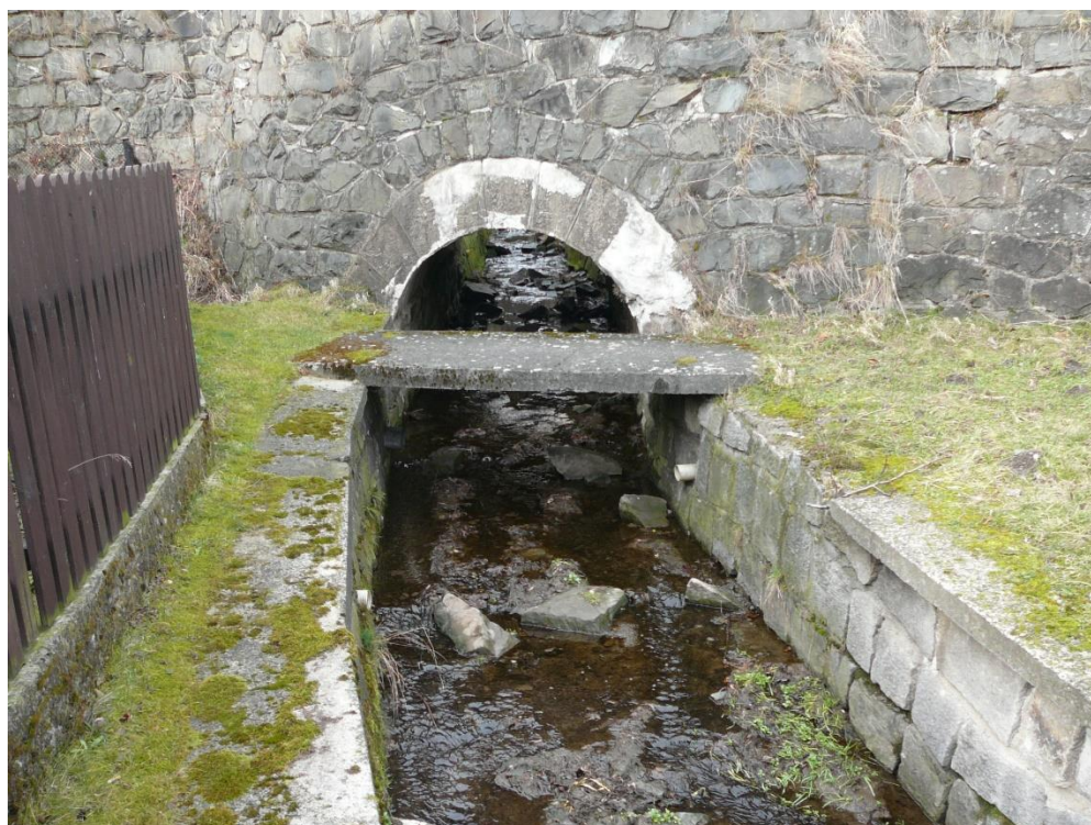
oprava ŽB římsy a kamenný zához do dna km 0,705 - 0,720
