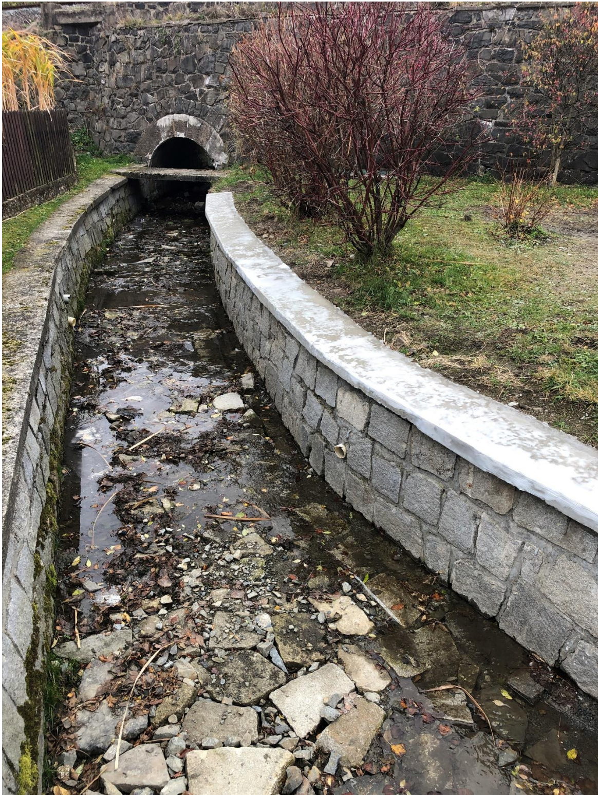
oprava ŽB římsy a kamenný zához do dna km 0,705 - 0,720
