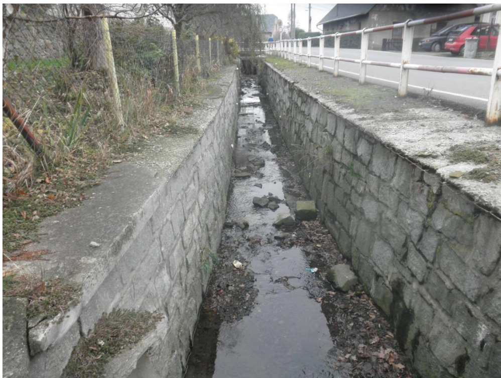
oprava ŽB římsy km 0,740 - 0,769
