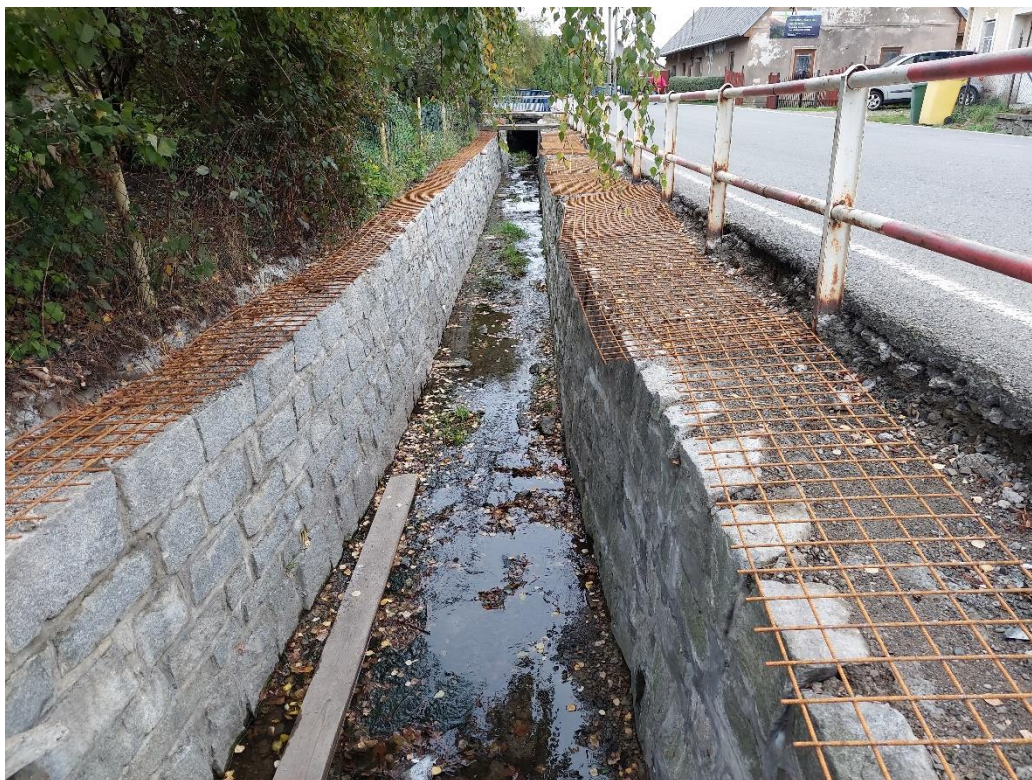
oprava ŽB římsy km 0,740 - 0,769
