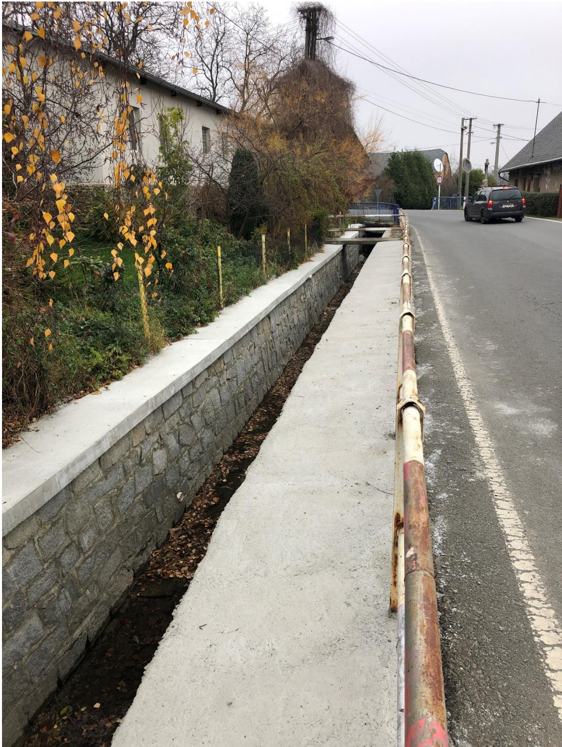
oprava ŽB římsy km 0,740 - 0,769
