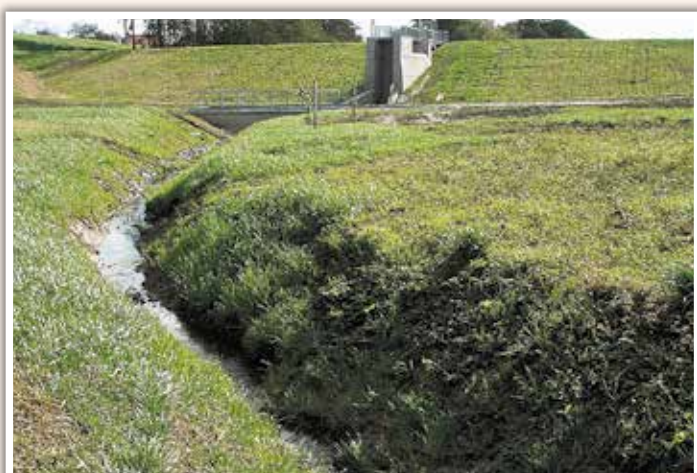
Pohled na sdružený objekt a hráz ze zátopě
