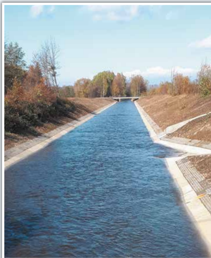
Přivaděč Vyšní Lhoty – Žermanice za převodu vody po opravě
