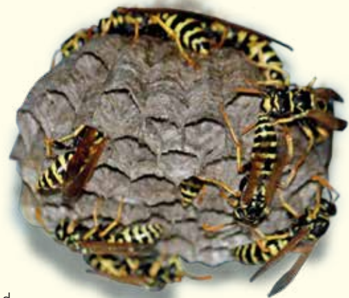
Hnízdo vosíka na fasádě budovy závodu F-M
