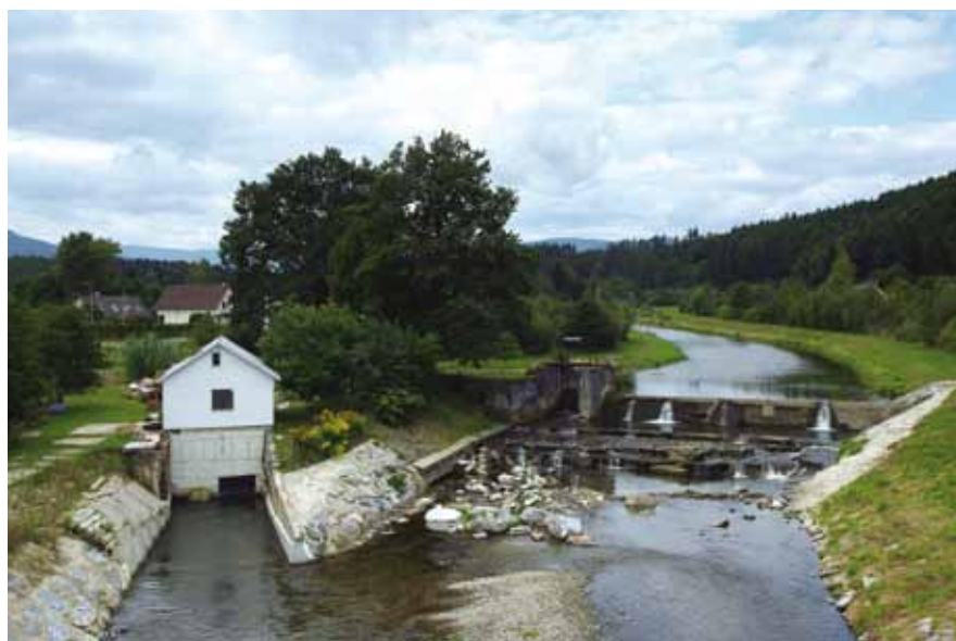
Obnovený jez na Bělé na horním konci Mikulovic (MVE Krejčí)
