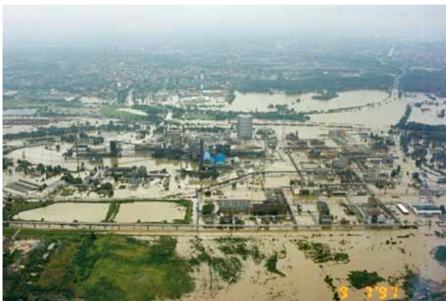
Letecký snímek lagun a samotné rafinerie OSTRAMO z července 1997
