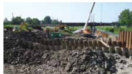
Provádění podélné štětové stěny
