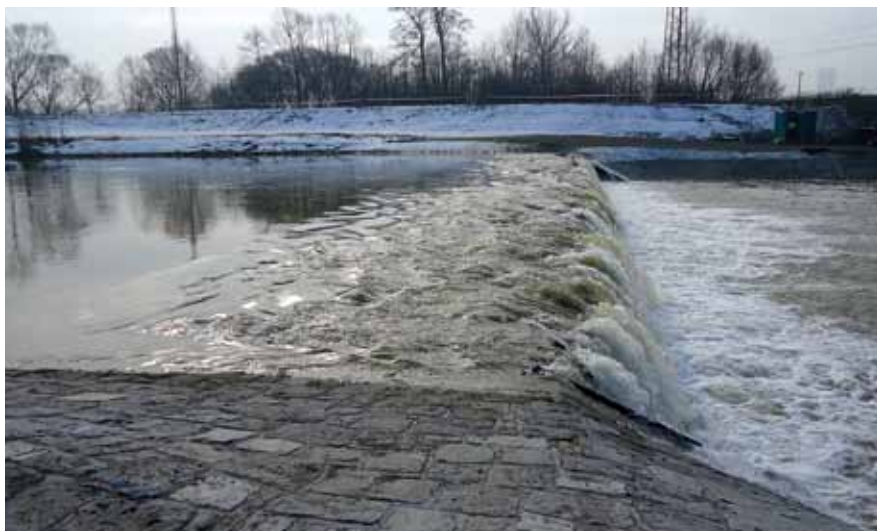
Stupeň po opravě
