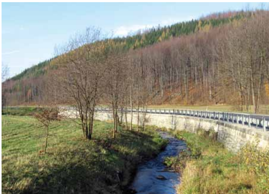
Po posledních povodních bylo třeba nově stabilizovat některé souběhy s komunikacemi (nad Vápennou)
