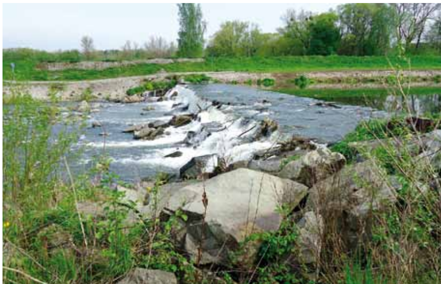
Stupeň před opravou
