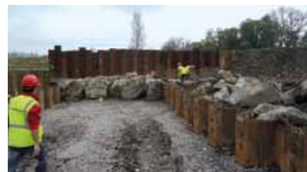
Balvanité opevnění přelivné plochy
