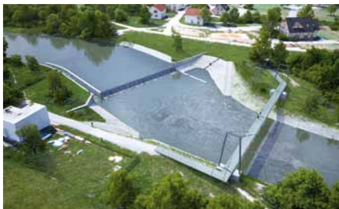
Nová konstrukce spádového stupně v ř. km 25,640 nahradí stávající stupeň, který je v technicky nevyhovujícím stavu
