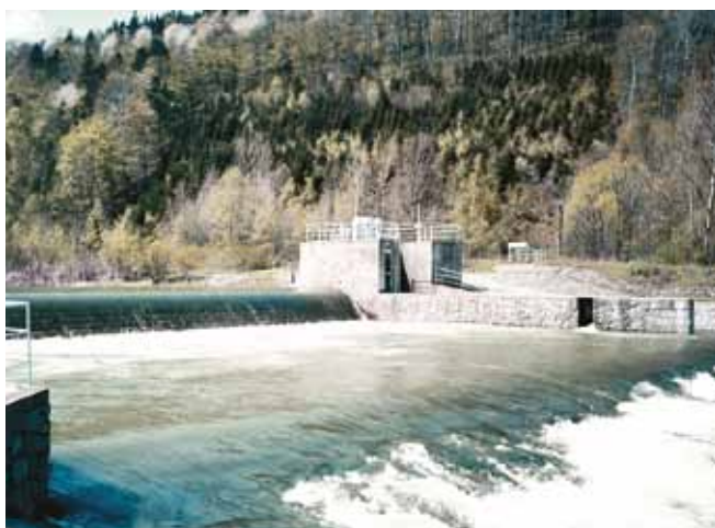
Jez v Hodoňovicích, vybudovaný kolem roku 1970, je u levého břehu opatřen rybím přechodem staršího typu
