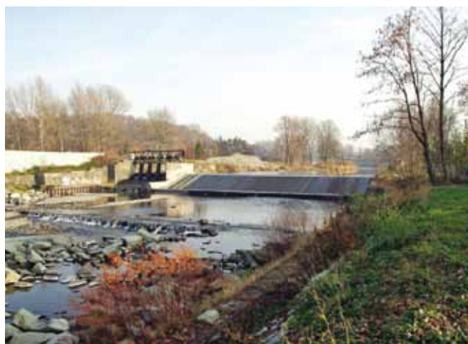
Jez v Lískovci u Frýdku zásobuje provozní vodou Válcovny plechu
