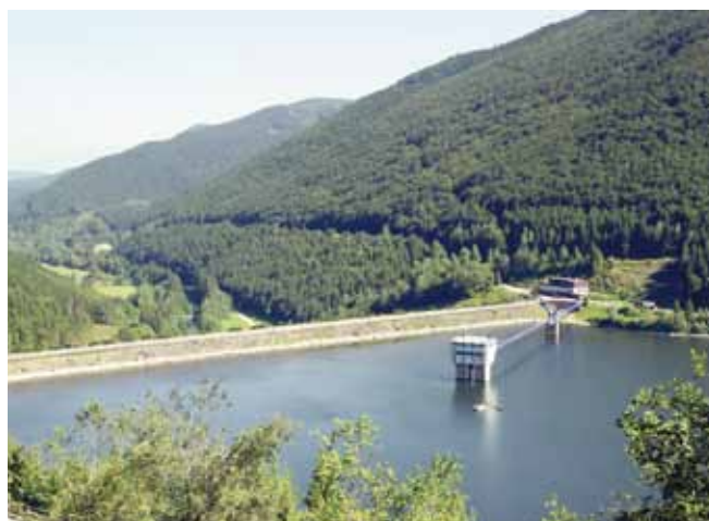
Sypaná zemní hráz údolní nádrže Šance typu „rockfill“ a odběrná věž z nádrže
