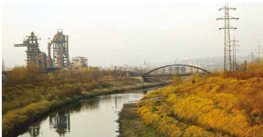
Úprava Ostravice z šedesátých let minulého století měla za účel ochránit na levém břehu Vítkovické železářny a na pravém vytvořit prostor pro odvalové hospodářství. Žofiina huť (na snímku asi z roku 1975) byla likvidována koncem sedmdesátých let, provoz v oblasti Dolních Vítkovic byl zastaven o 15 let později. Jejich prostor je dnes součástí centra Ostravy
