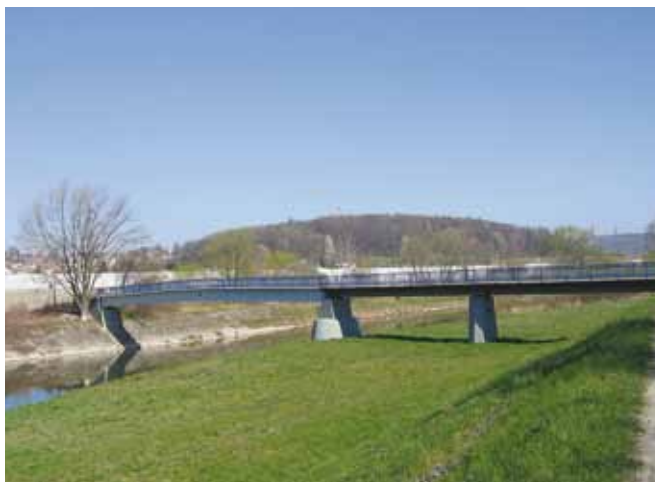
Souběh Odry s dálnicí D1 v levobřežním prostoru poblíž Hošťálkovické lávky
