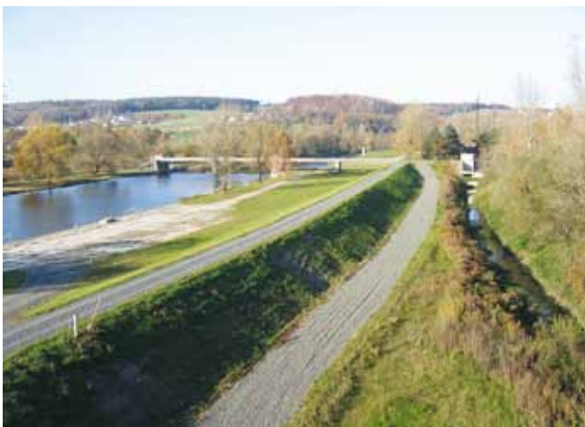
Nadjezí Lhoteckého jezu se souběžnou pravobřežní hrází a havarijním profilem na toku
