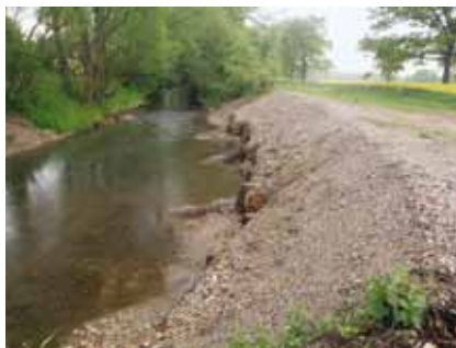
Prudník – biotechnická sanace nátrže – srubová stěna
