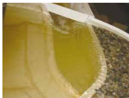
Bezpečnostní přeliv VD Morávka, současný stav Q = 282 \text{ m}^3/\text{s}
