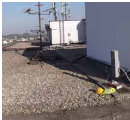
Původní střecha na Varenkové
