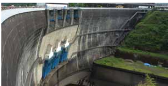
Přehrada Kanaido – klenbová hráz
