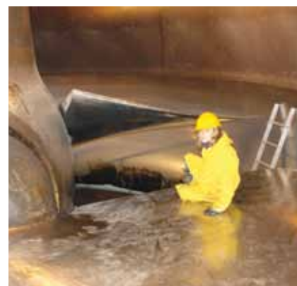
Oběžné kolo Kaplanovy turbíny na VD Gabčíkovo má průměr 9,4 m
