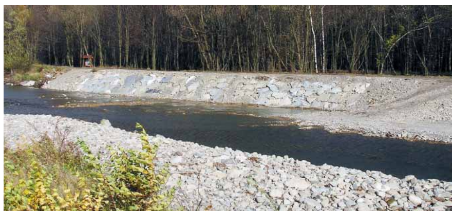
Morávka po opravě
