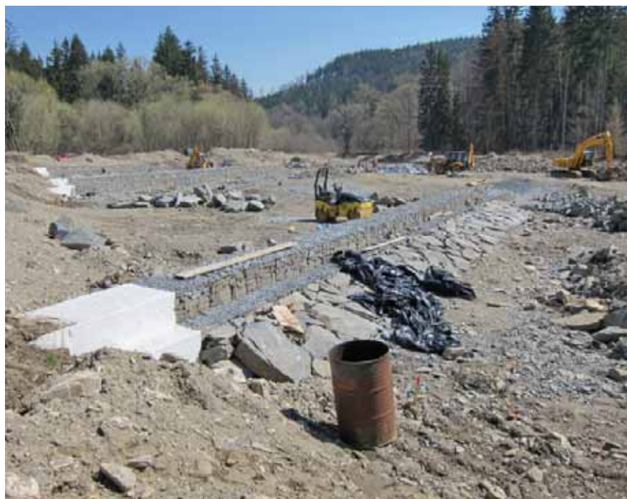
Výstavba drátokamenných výhonů na Opavě v Karlovicích-Zadní Vsi
