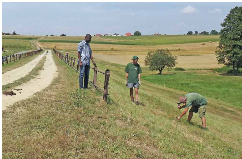
Spolupracujeme s odborníky z celého světa – Ing. Zoglobossou kontroluje instalaci elektrod odporové tomografie na VN Markvartovice F
