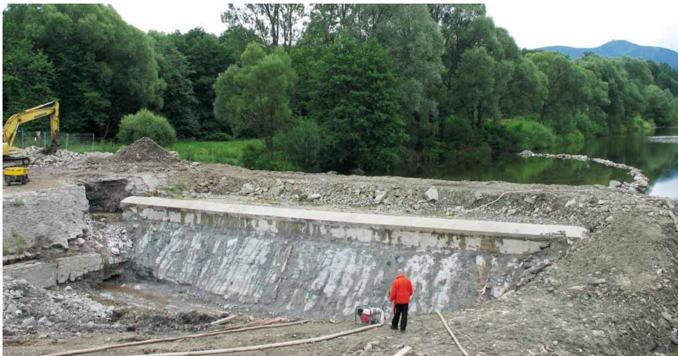
Pohled na opravu jezu v Pržně
