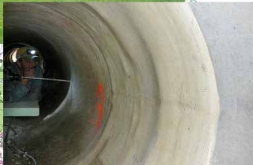
VN Markvartovice E/I – oprava poruchy potrubí spodní výpusti
