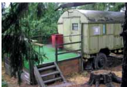
Nepovolená stavba na k.ú. Razová
