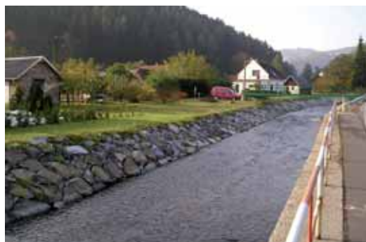
Odstranění povodňových škod na Opavici v roce 2010
