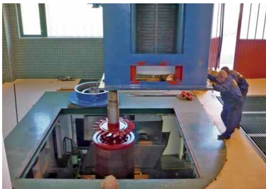
Montáž generátoru TG1
