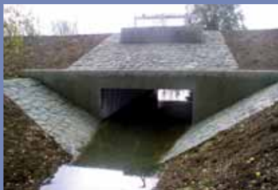
Propustek. Tato stavba bude regulovat průtok vody v době povodní.
