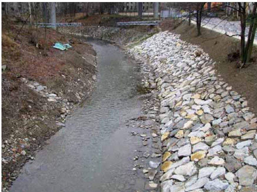
Opravené koryto Jičínky v Šenově
