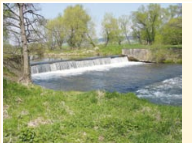
Jeden ze starších pevných jezů v hraničním úseku řeky Opavy.
