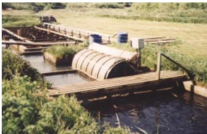
Biologické čištění recirkulované vody.
