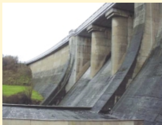
Pohled na hráz přehrady Žermanice
