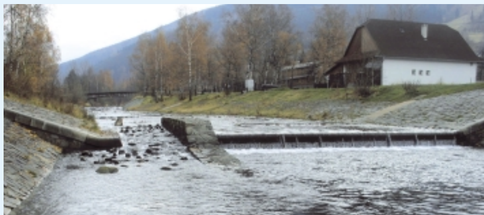
VT Morávka ř. km 17,045 - funkční rybní přechod - drsná rampa u stupně protažená do oblasti vzdutí
