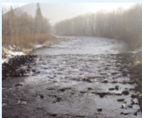
VT Ostravice ř. km 40,610 (bývalý Barthův jez) - funkční rybní přechod - drsná balvanitá rampa foto Lojkásek
