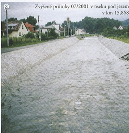
2 Stavba: 795 Bělá, Jeseník km 15,640-16,468 Cena stavebních prací: 14,9 mil. Kč
