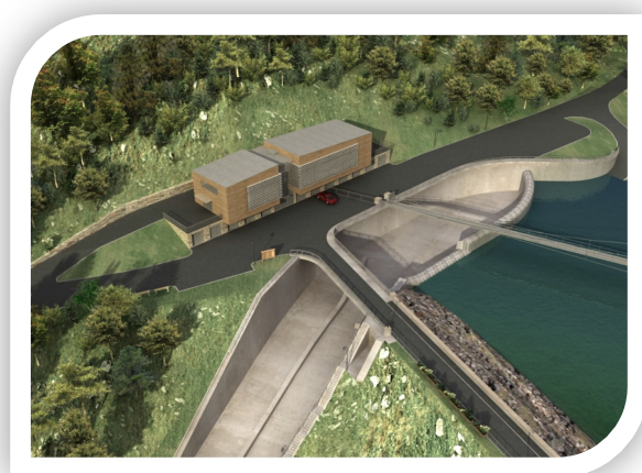
Provozní středisko, přeliv a skluz – navrhované řešení
