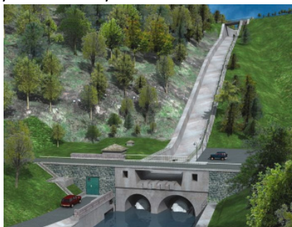
Skluz a strojovna spodních výpustí a vývar – současný stav
