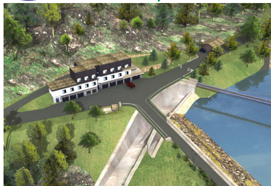
Provozní středisko, přeliv a skluz – současný stav
